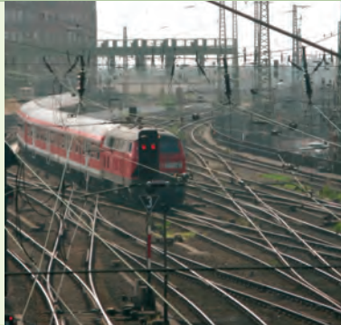
Gleisanlagen der DB
